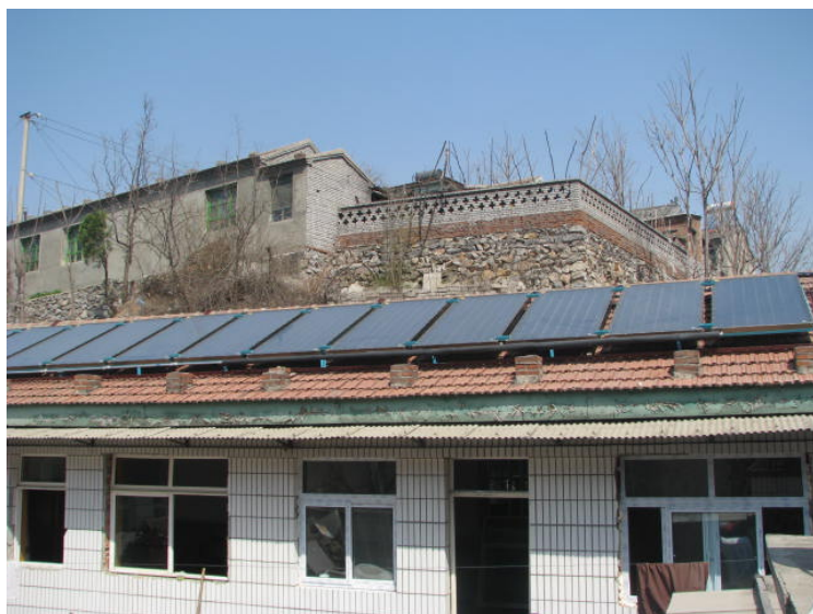
安装集热器后建筑物外观
