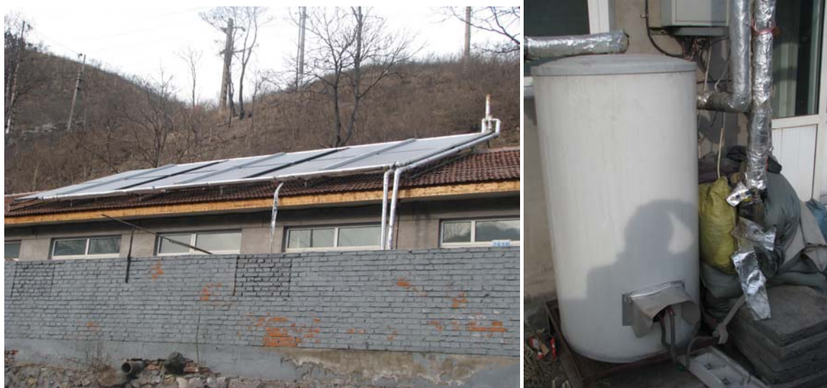
安装集热器后建筑物外观
