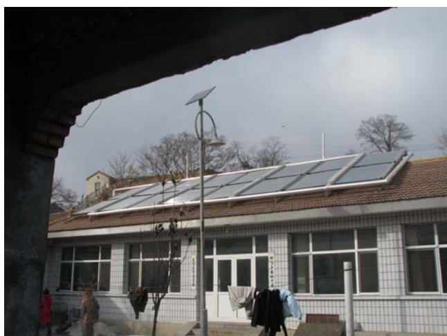
安装集热器后建筑物外观
