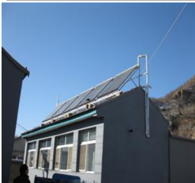
安装集热器后建筑物外观
