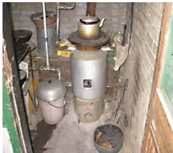
辅助用燃煤锅炉
