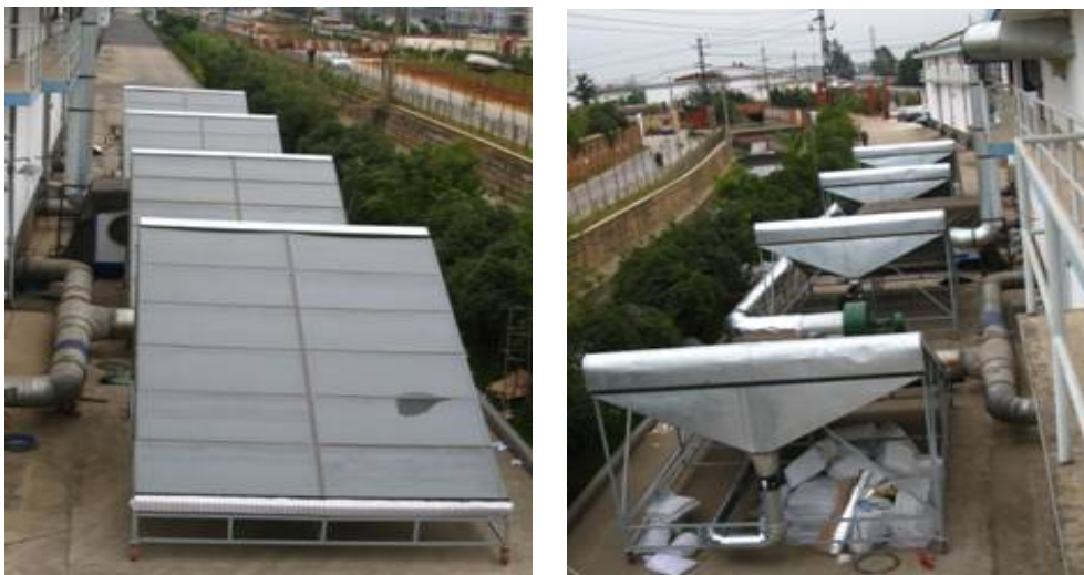
图 2-13 太阳能辅助热泵干燥系统实物图
