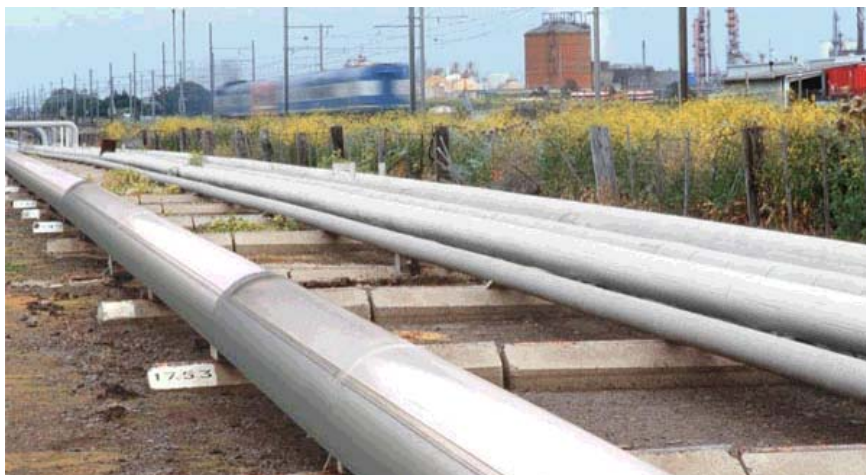
图 4-20 太阳能稠油输油管外观
