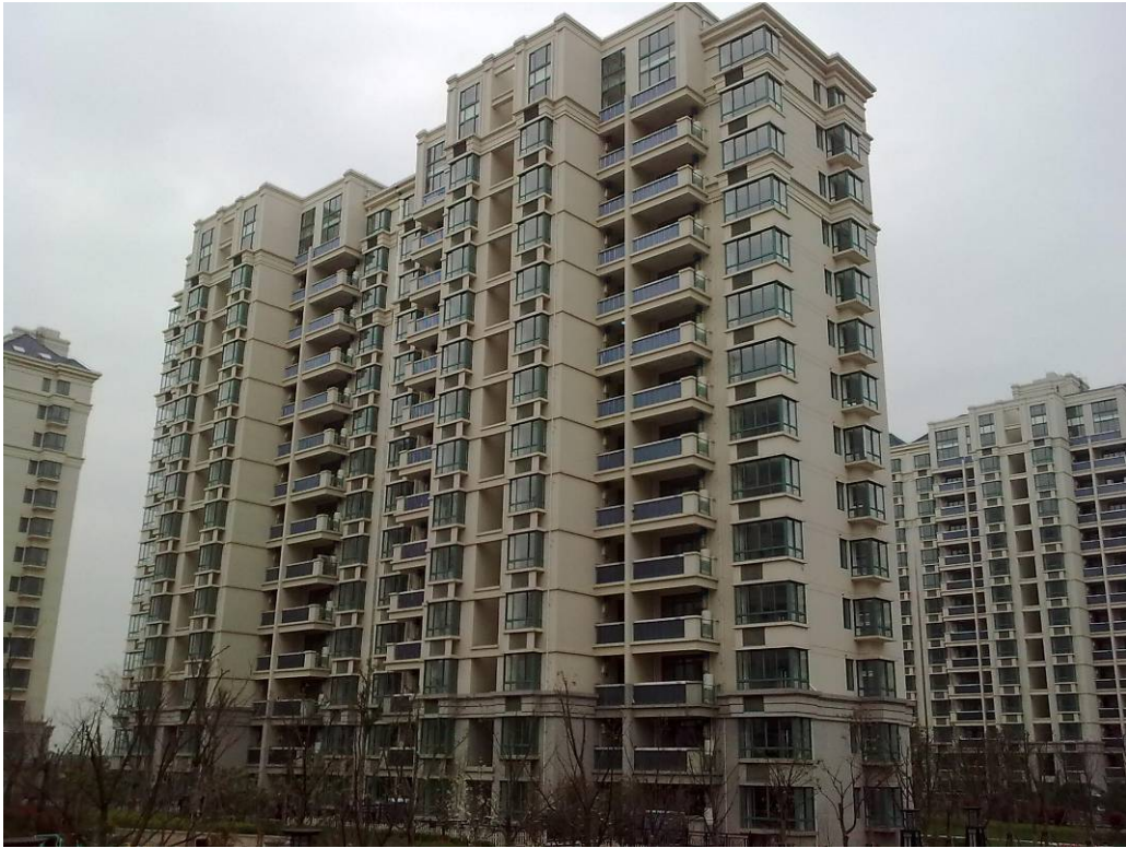
图2-3 三湘四季花城阳台壁挂式太阳能热水系统
