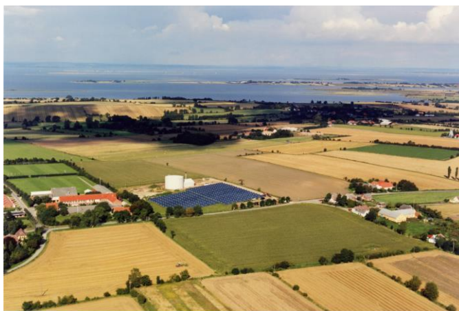
丹麦 Rise 太阳能+生物质能区域供热项目
