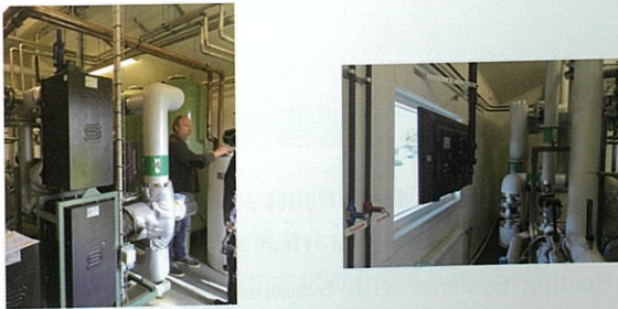
集热场换热站 系统运行参数展示窗口（可查看太阳能保证率）
