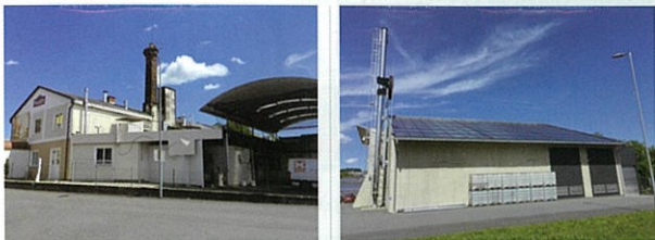
已废弃的天然气锅炉热站 新的太阳能热站
