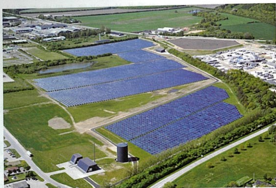
图5 Vojens太阳能热站全景图（右上侧为坑式储热水池）
