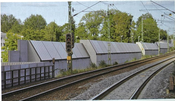
图29 平板太阳能集热器隔音墙
